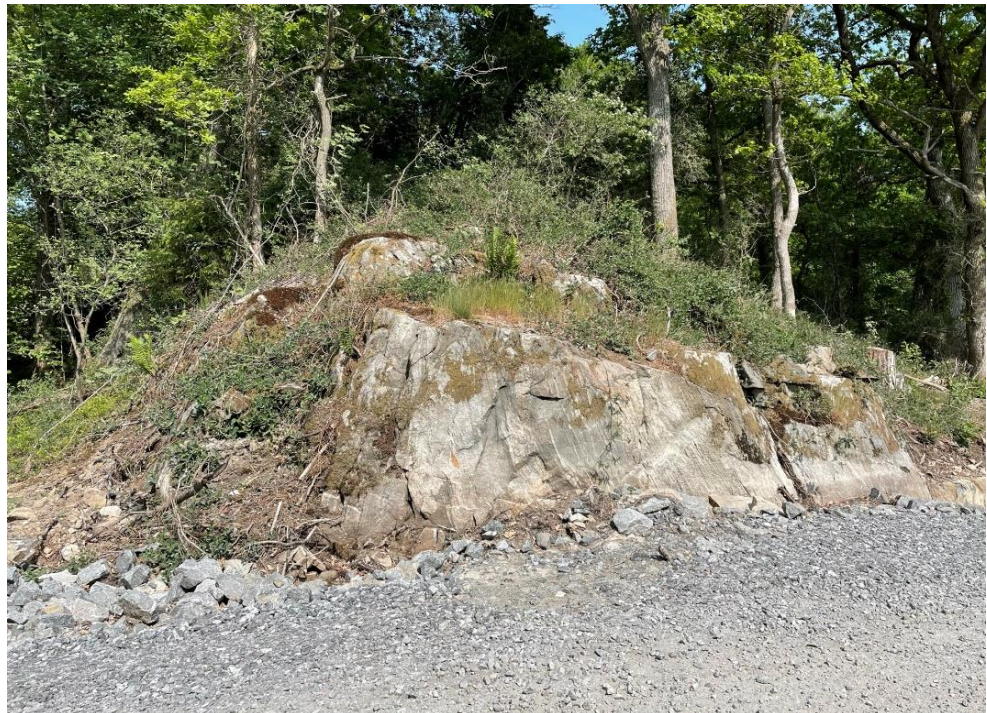
Figur 14. Berget vid arbetsväg i den västra delen av området är framsprängt.
